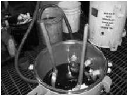
Figura 7: Apariencia del aceite dieléctrico de este transformador fallado
