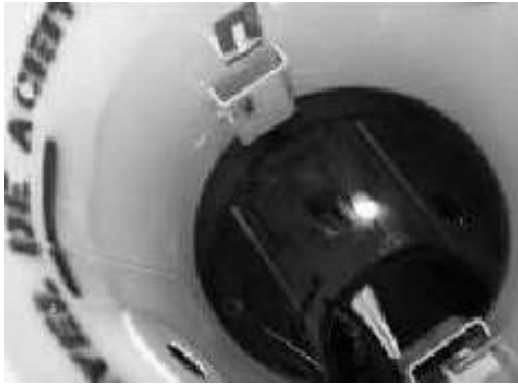
Figura 5: Apariencia del aceite dieléctrico de este transformador fallado
